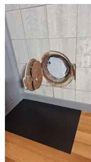
Selger har etter befaringen montert sotlukestein/plate og montert plate på gulv ved sotluke for å ivareta brannsikkerheten.
