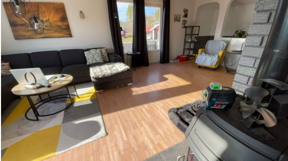
1. etasje Plassering av laser ved kontroll av stue. Det er målt 14 mm høydeforskjell gjennom rommet. TG 1
