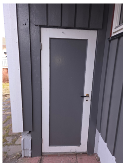
Dør til kjellernedgang, enkel uisolert dør
