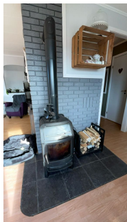
Rentbrennende vedovn i stue 1. etasje fra 2019
