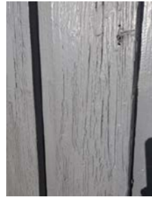
Det er værslitt/oppsprukket trevirke/trepaneler på vegg mot sør og vest
