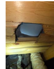
På hvert hjørne av boligen er papiret på isolasjon revet opp av ukjent årsak.
