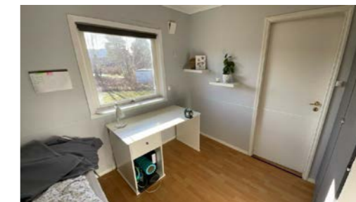
1. etasje Plassering av laser ved kontroll av soverom 3. Det er målt 7 mm høydeforskjell gjennom rommet. TG 1
