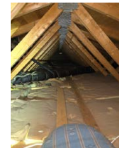
Ingen synlig ventilering av takkonstruksjon mot carport og trapp ned til kjeller sett fra kryploft
