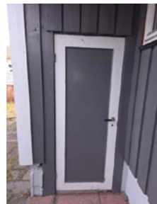
Dør til kjellernedgang, enkel uisolert dør
