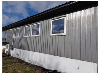
Det er værslitt/oppsprukket trevirke/trepaneler på vegg mot sør og vest
