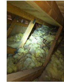
På hvert hjørne av boligen er papiret på isolasjon revet opp av ukjent årsak.
