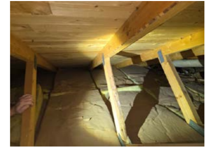
Ingen synlig ventilering av takkonstruksjon mot carport og trapp ned til kjeller sett fra kryploft
