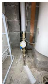
Hovedstoppekrane med vannmåler
