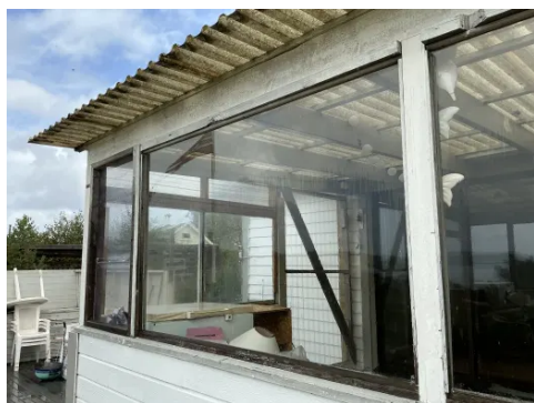
Arbeid med vindu/glass i hagestue er ikke fagmessig utført og tetting er usikker.
