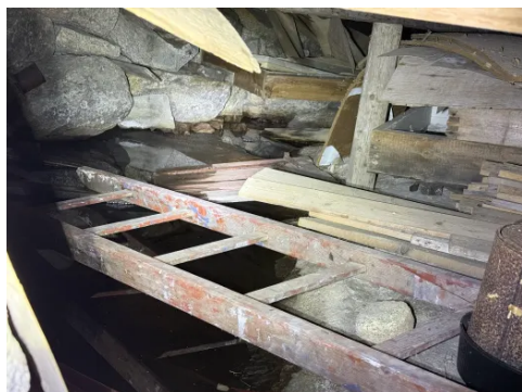
Større vannansamling i krypkjeller.
