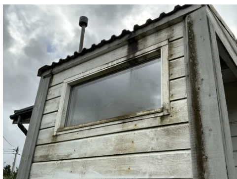
Arbeid med vindu/glass i hagestue er ikke fagmessig utført og tetting er usikker.
