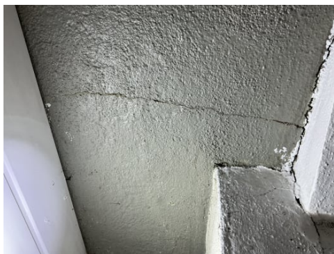
Sprekk på innvendig puss.
