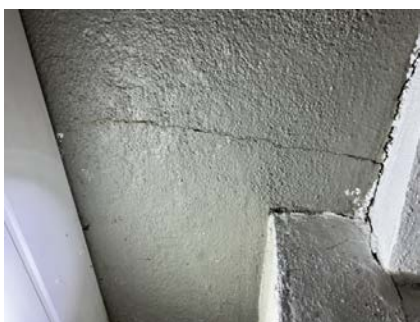
Sprekk på innvendig puss.
