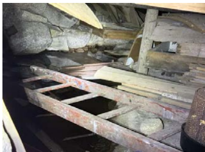
Større vannansamling i krypkjeller.
