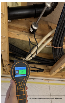
Bilde fra OCAB vedr, sanering av etasjeskille under badetom 1.etasje
