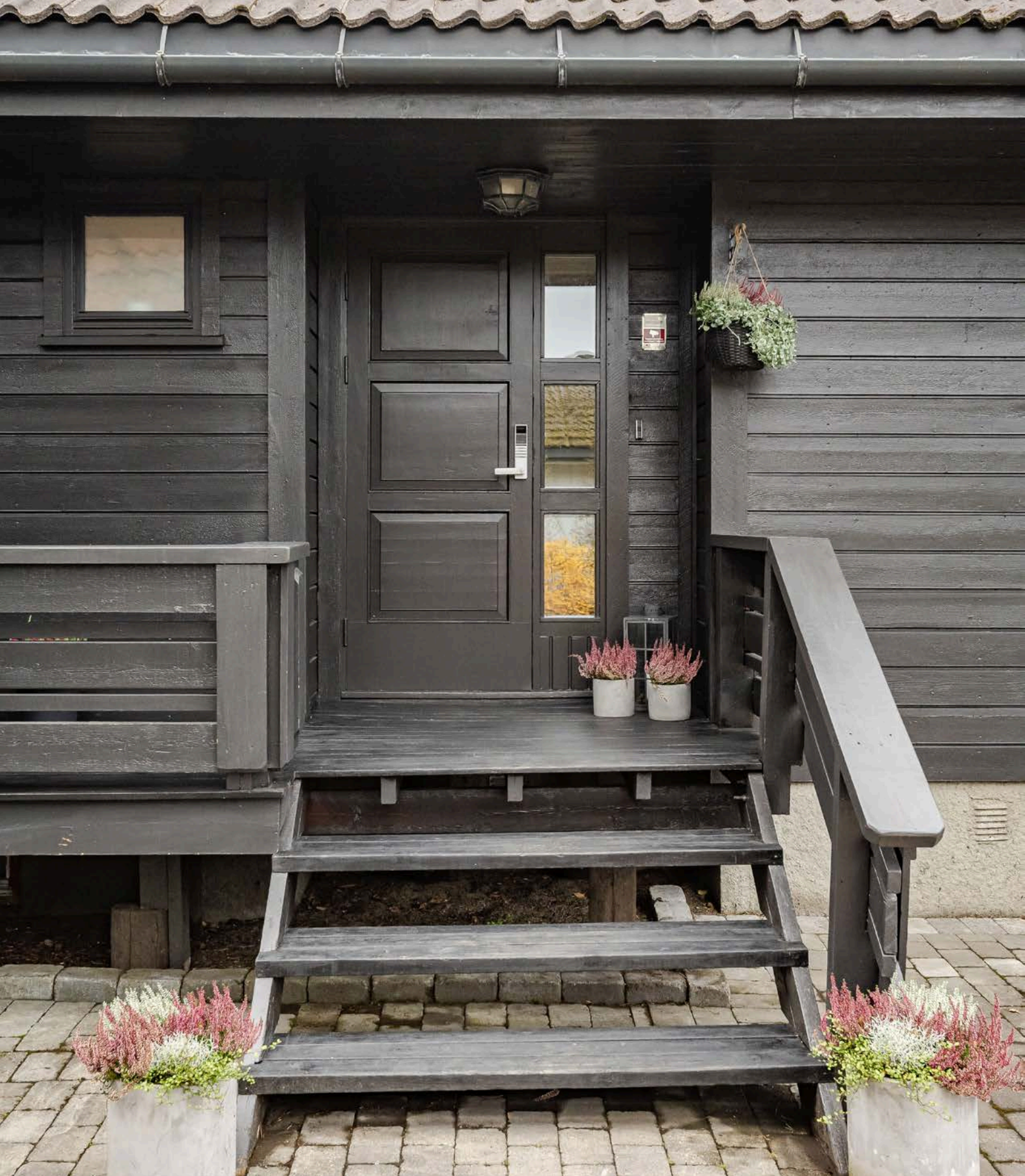
Praktisk med kodelås montert på ytterdøren, utebelysning i himlingen og ringeklokke montert på ytterveggen.
