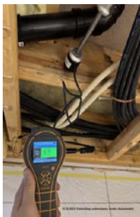
Bilde fra OCAB vedr. sanering av etasjeskille under baderom 1.etasje
