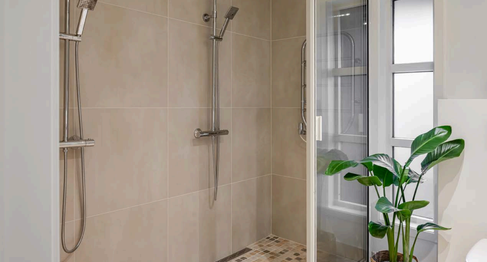
Romslig dusjsone oppgradert i 2025 med bla. nye fliser, nytt sluk og slukmansjetter.
