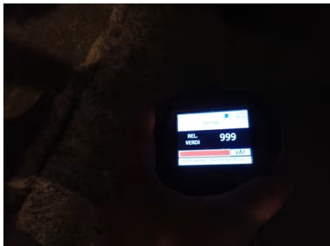
Fuktmåling på grunnmur
