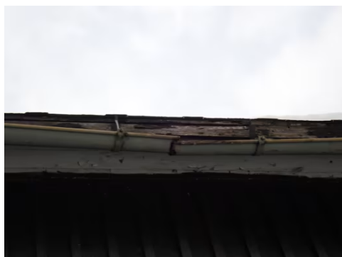
Skadet takrenne kan ha forårsaket skade i veggkonstruksjon
