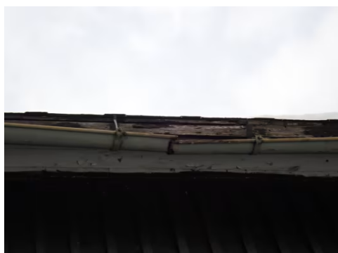
Skadet takrenne
