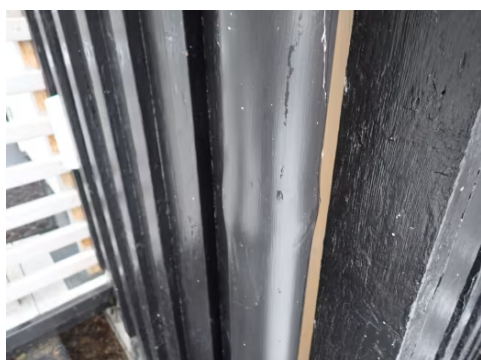
Skadet takrenne
