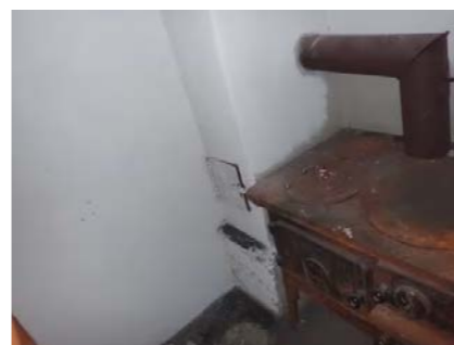
Rust i ovn
