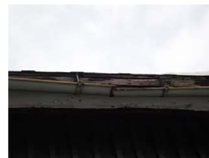
Skadet takrenne
