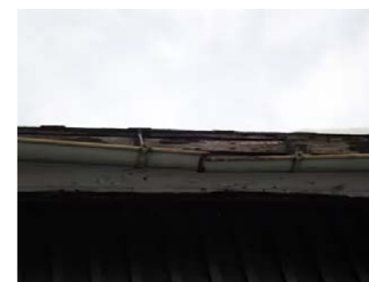
Skadet takrenne kan ha forårsaket skade i veggkonstruksjon
