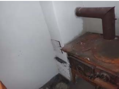
Rust i ovn
