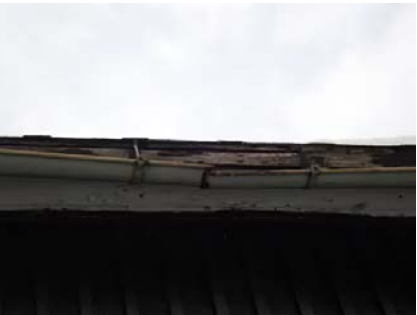
Skadet takrenne
