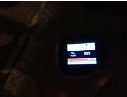
Fuktmåling på grunnmur
