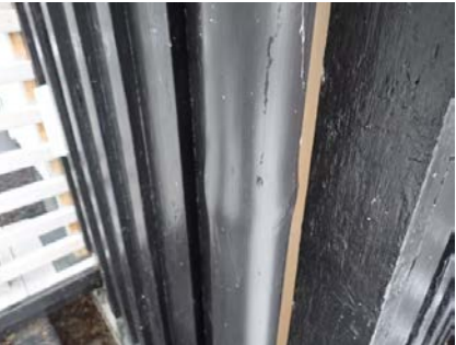
Skadet takrenne
