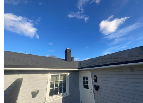
Taktekking over inngangspart
