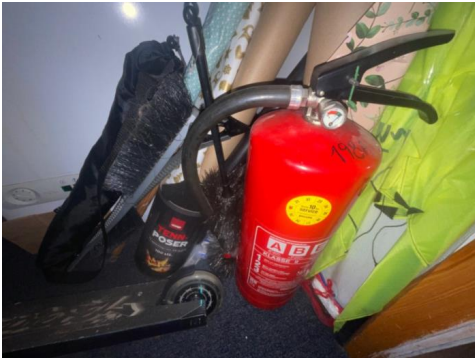
Slokkeapparat i boden
