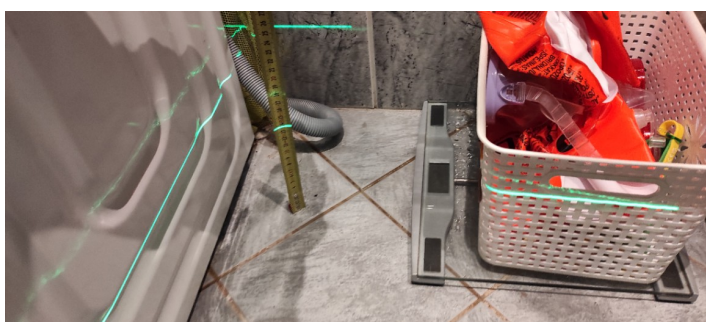
Kontroll av fall mot sluk.
