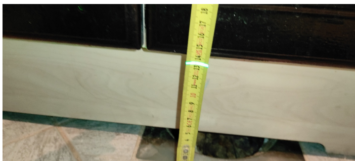
Kontroll av fall mot sluk.
