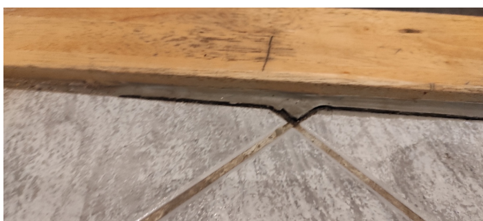
Kontroll av fall mot sluk.
