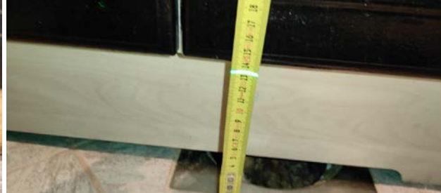
Kontroll av fall mot sluk.
