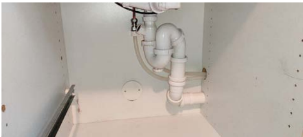
Kontroll av røropplegg.
