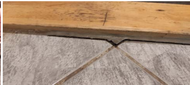
Kontroll av fall mot sluk.
