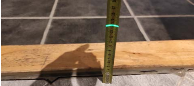
Kontroll av fall mot sluk.
