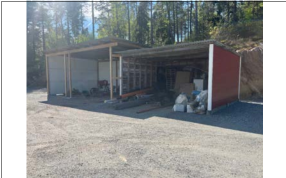
Enkelt lagerbygg med åpen front. Bygget er ikke omsøkt eller godkjent.
