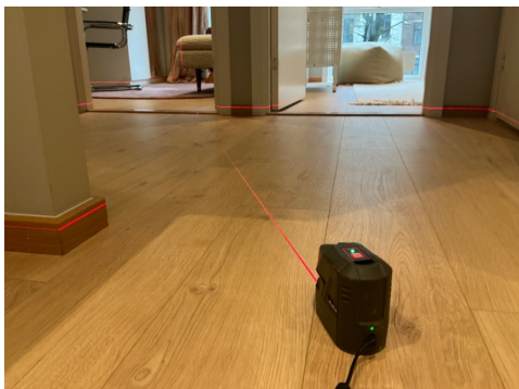
Nivellering soverom, ingen registrerte avvik
