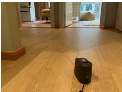
Nivellering soverom, ingen registrerte avvik
