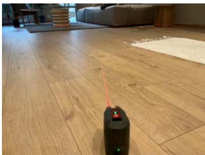
Nivellering stue/kjøkken, ingen registrerte avvik
