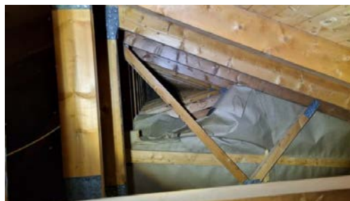
Begrenset innspeksjonsmuligheter av deler av kaldloftet.
