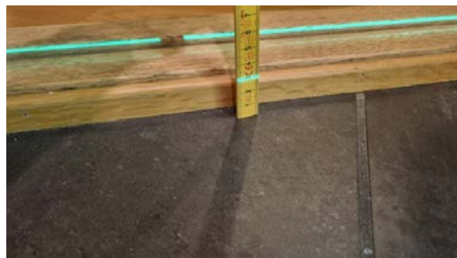
Kontroll av fall til sluk.
