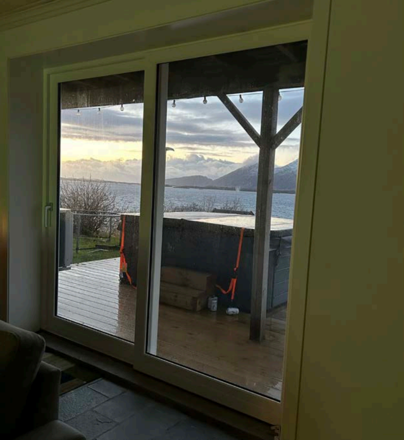
Skyvebalkongdør i stue i sokkeletasje satt inn i 2024 (privat foto)
