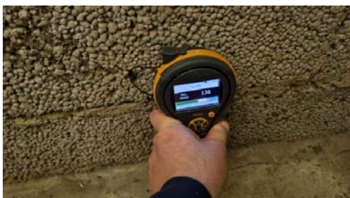
Ingen unormale fuktverdier ble registrert ved befaring.
