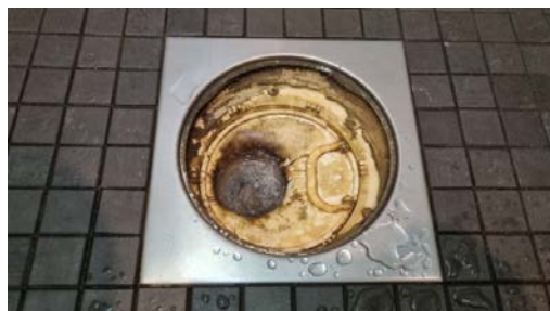
Kontroll av sluk i dusjnische.
