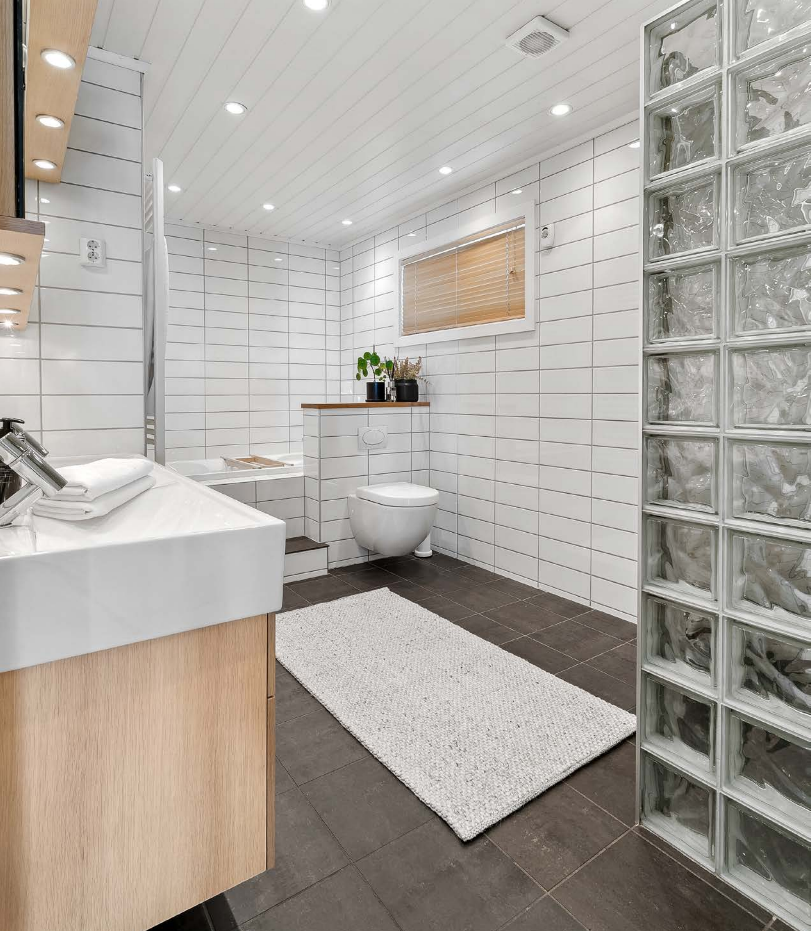
Gulvet på badet er flislagt. Rommet har elektriske varmekabler i gulvet.
