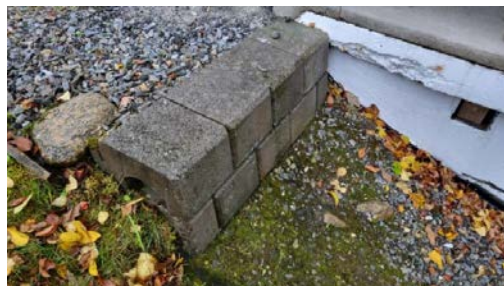
Støttemur av betongstein.
