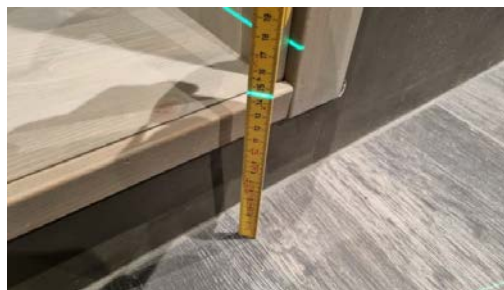
Kontroll av fall.
