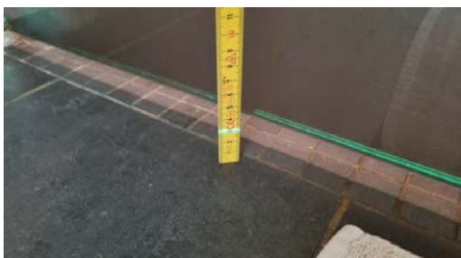
Kontroll av fall til sluk.
