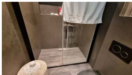
Oversiktsbilde av bad/wc i sokkeletasjen.
