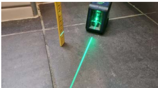
Kontroll av fall til sluk.
