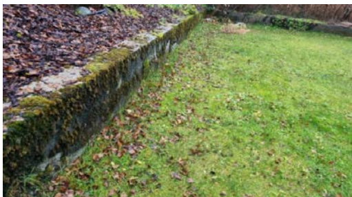
Støttemur av betong.
