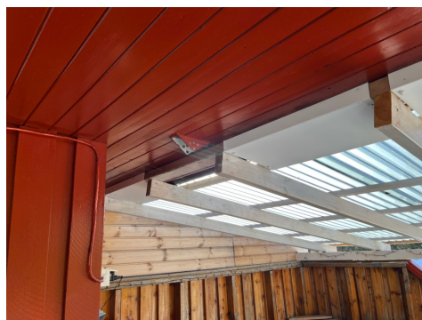
underdimensjonert takkonstruksjon
