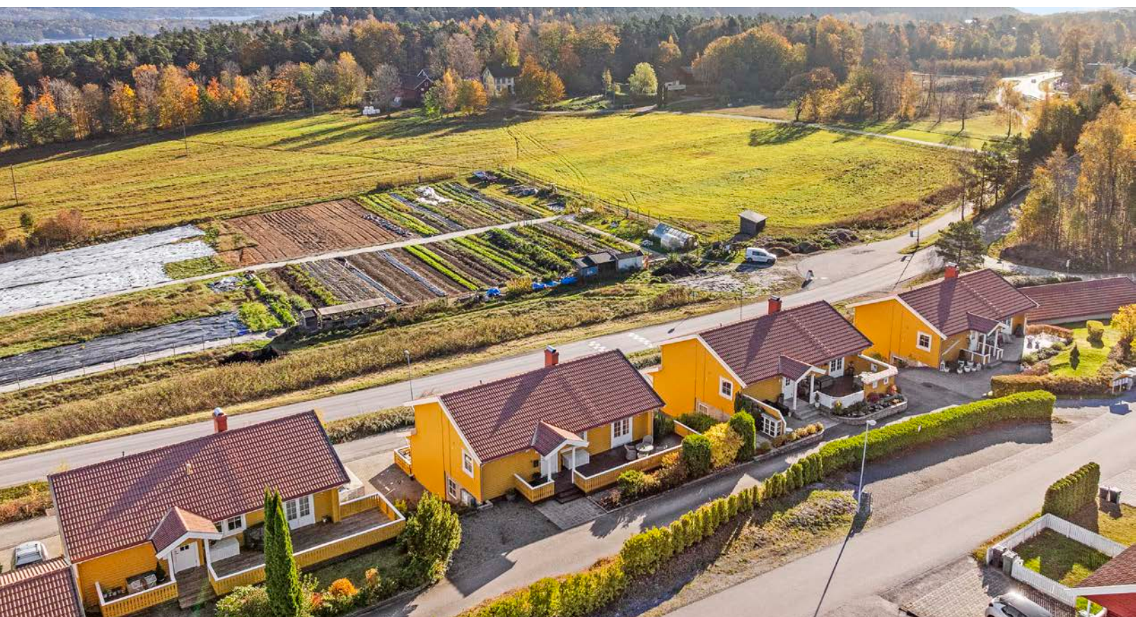
Veldrevet borettslag med fint opparbeidet uteområde.
