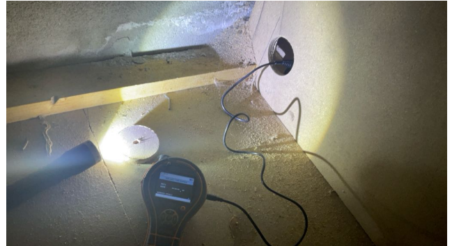
Hulltaking er foretatt i vegg fra tilstøtende bod.
