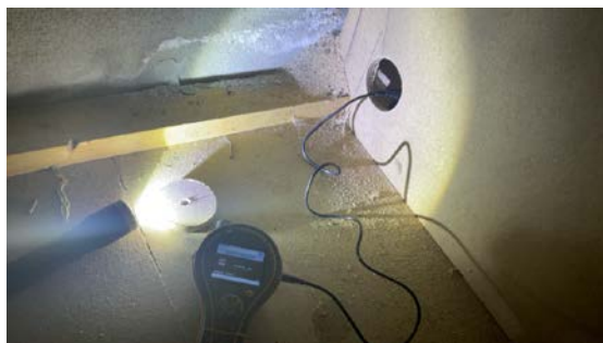
Hulltaking er foretatt i vegg fra tilstøtende bod.
