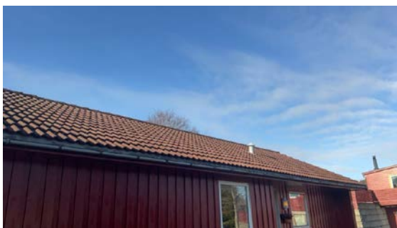
Taket er tettet med betongtakstein fra byggeåret.
