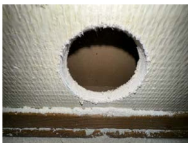
Hulltaking i tilstøtende toalettrom
