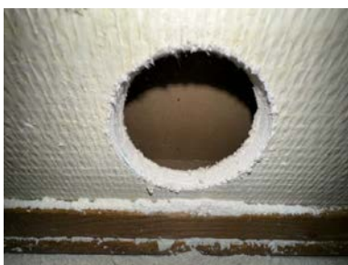
Hulltaking i tilstøtende toalettrom
