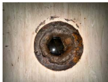
Sluk i støpejern fra byggeår
