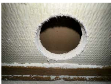
Hulltaking i tilstøtende toalettrom
