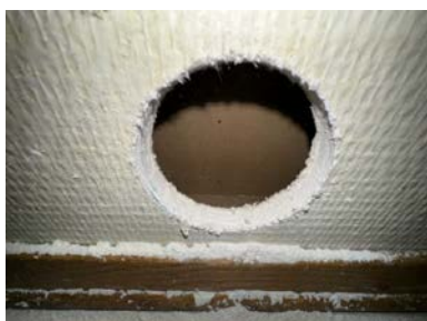
Hulltaking i tilstøtende toalettrom
