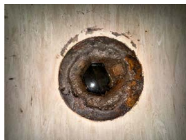
Sluk i støpejern fra byggeår
