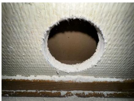
Hulltaking i tilstøtende toalettrom
