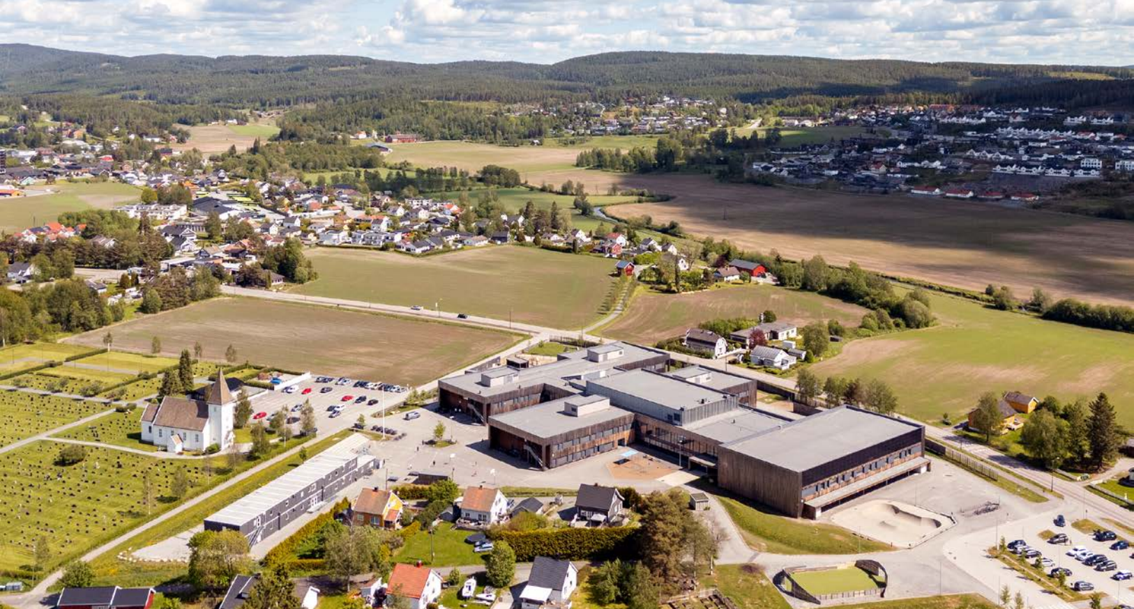
Fra leiligheten er det gang/sykkelavstand til Bjørkelangen Skole (1-10. klasse) som stod ferdig i 2018
