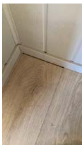
Ende på laminat ikke skjult av list.
