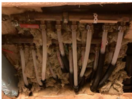
Fordeling for rør i rør
