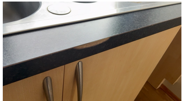
Skade på benkeplate ved vask.
