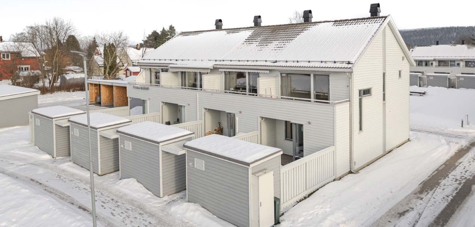
Alle vinduer og dører er fra byggeåret 2007 og har isolerglass.
