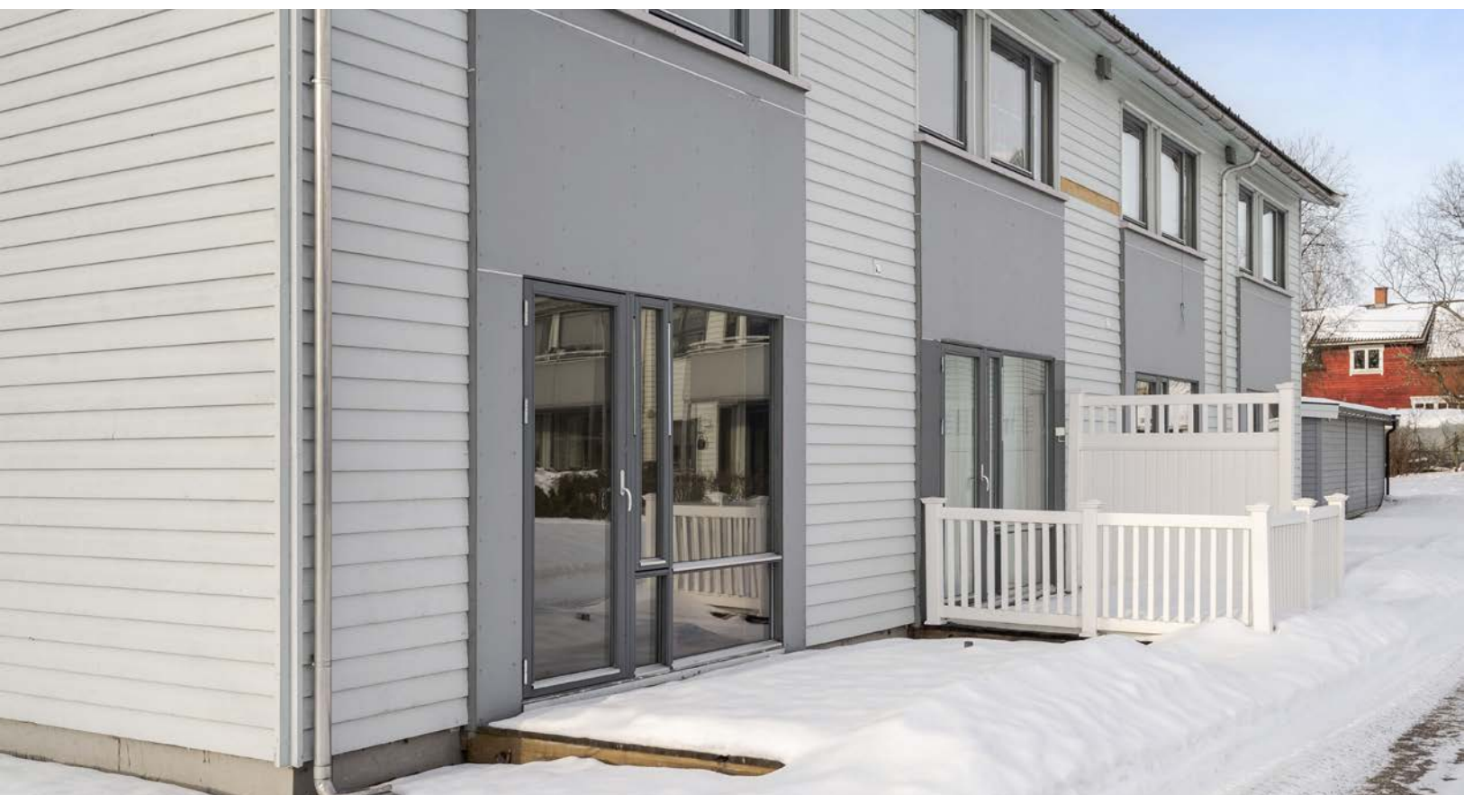
Platting med utgang fra hovedsoverommet i 1. etasje. Verandadør av tre med isolerglass.
