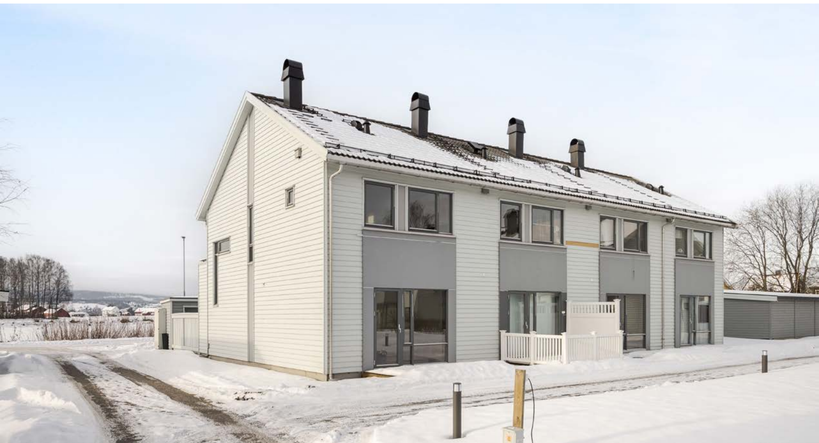
Bygningen har en takkonstruksjon med naturlig ventilering og er isolert med mineralull.
