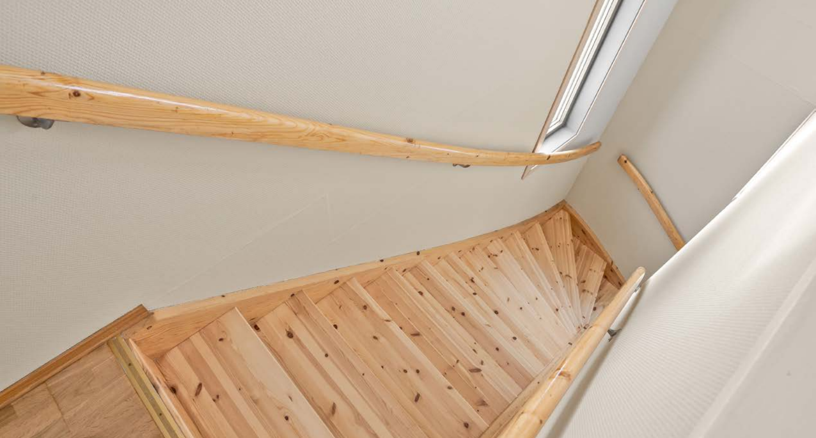
Tretrapp mellom etasjene.
