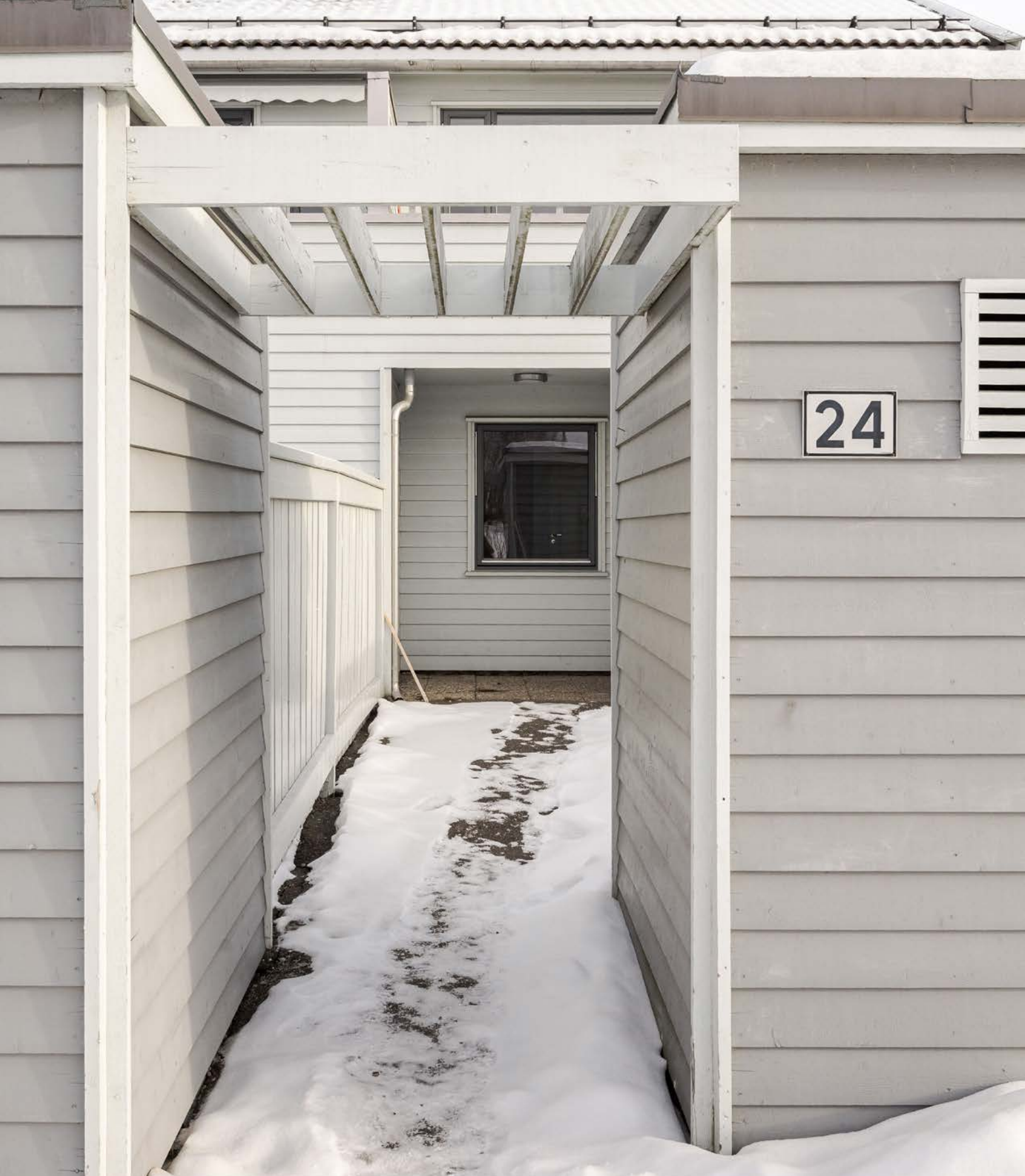
Inngangspartiet har en overbygd gangvei med tilknytning til bod.
