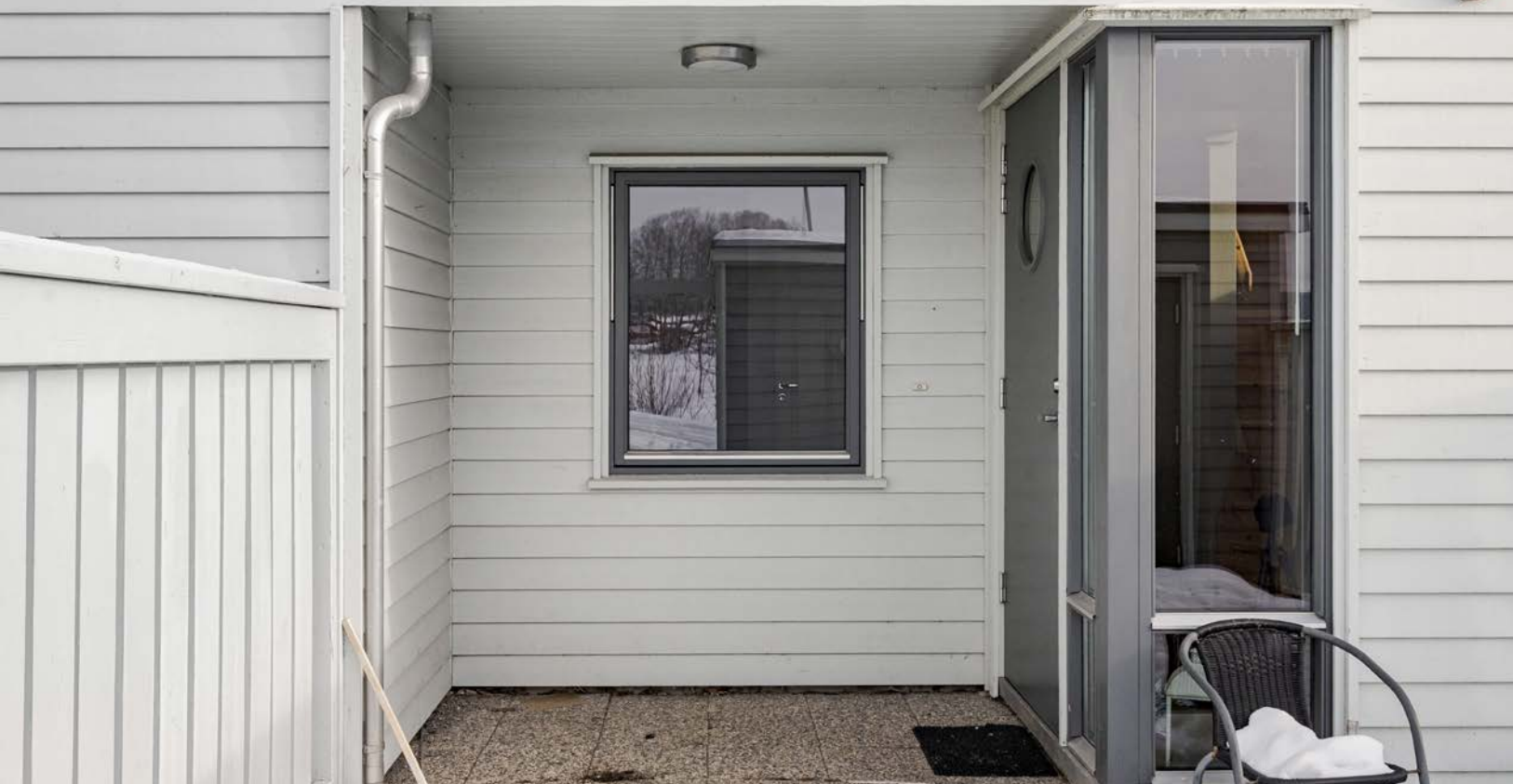
Overbygd inngangsparti med hellelagt område foran inngangsdøren.
