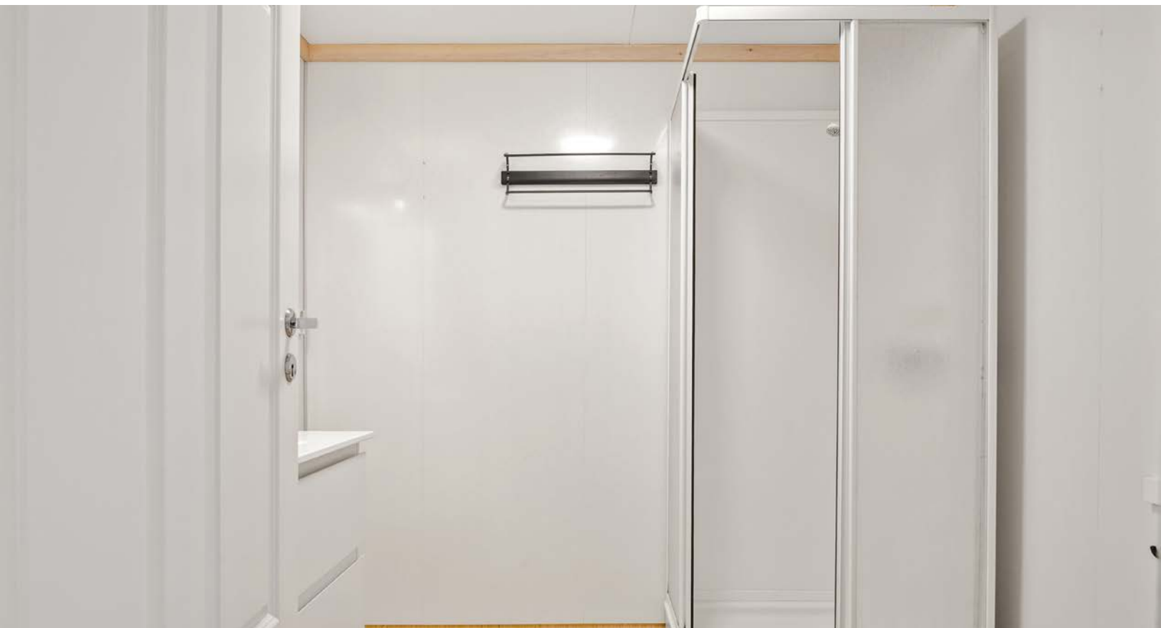
Gulvbelegg med varmekabler og baderomsplater på veggene.
