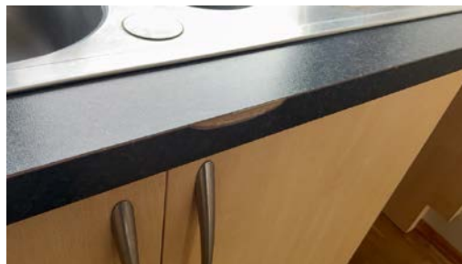
Skade på benkeplate ved vask.
