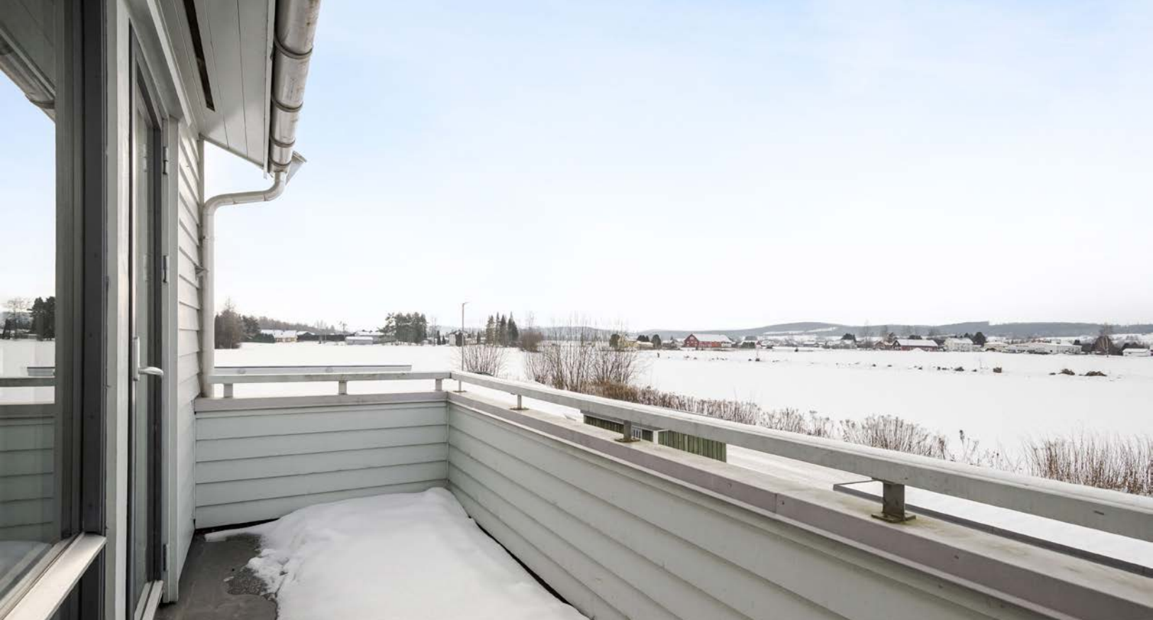
Balkongen har rekkverk av tre og folie på gulvet.
