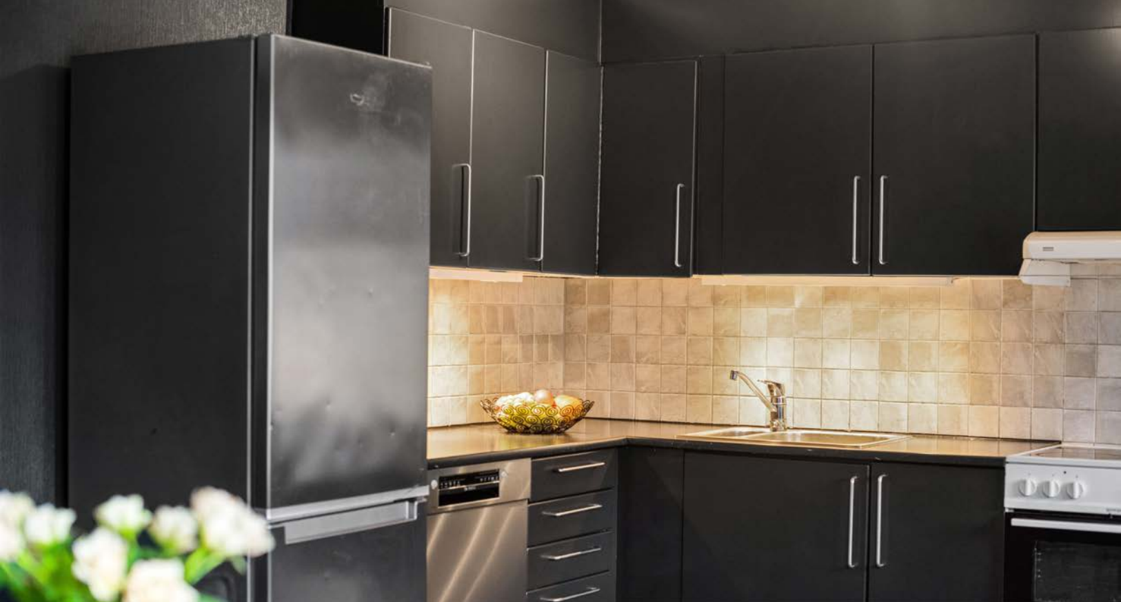
Kjøkkeninnredningen har glatte fronter som er malt i senere tid, samt fliser over kjøkkenbenk.
