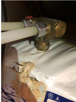
Bilde av lekkasje på kobling til varmtvannsberederen
