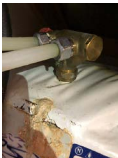
Bilde av lekkasje på kobling til varmtvannsberederen
