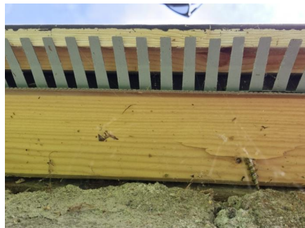
Det er montert musebånd på gavlvegger.
