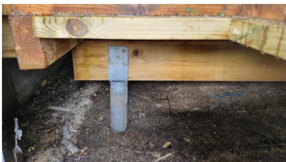
Markterrasse er fundamentert på jordskruer.
