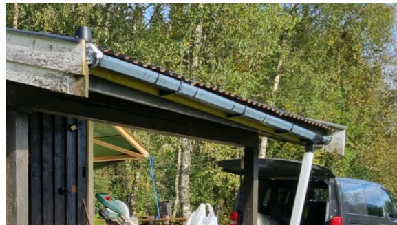
Renner og nedløp av plast på takutstikk mot øst.
