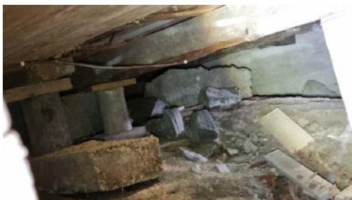
Visuell besiktigelse av krypkjeller via utsparing/ventil i grunnmur.
