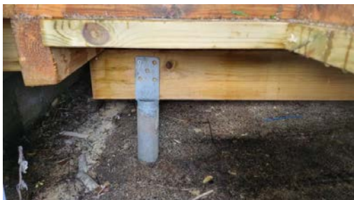
Markterrasse er fundamentert på jordskruer.
