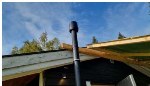
Lufting fra forbrenningstoalett.
