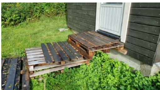
Provisorisk trapp uten rekkverk.
