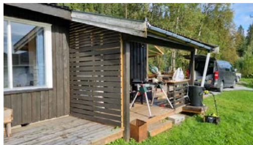
Deler av markplattingen er takoverbygget.
