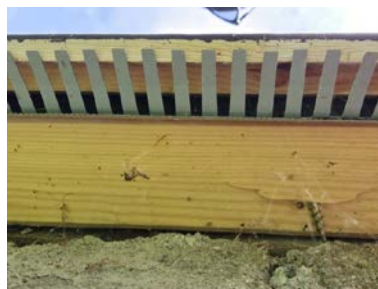
Det er montert musebånd på gavlvegger.
