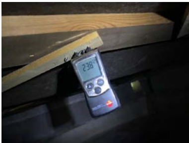
Det måles skadelig fuktinnhold i treverk.
