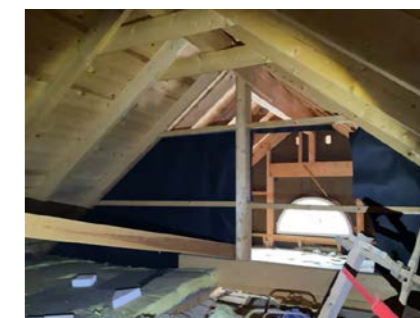
Loft over del mot syd.
