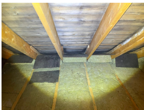
Loft over tilbygd del mot nord.
