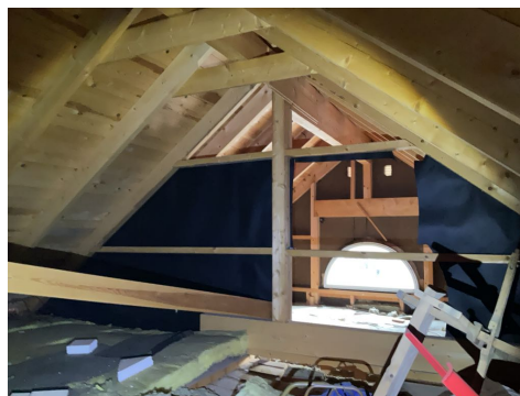
Loft over del mot syd.
