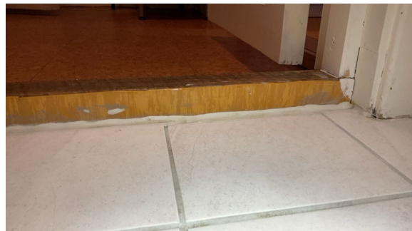
Det er oppbrett av eldre belegg ved terskel, men dette er skåret og ikke sveiset ved omramning.
