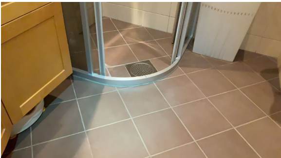
Det er ikke spalte i terskel mot sluk, slik at evt. lekkasjevann vil renne ut av våtrommet i stedet for ned i sluk.
