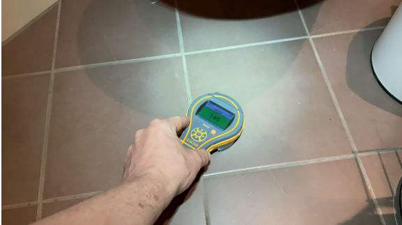
Med enkle fuktsøk ble det ikke registrert unormale verdier.
