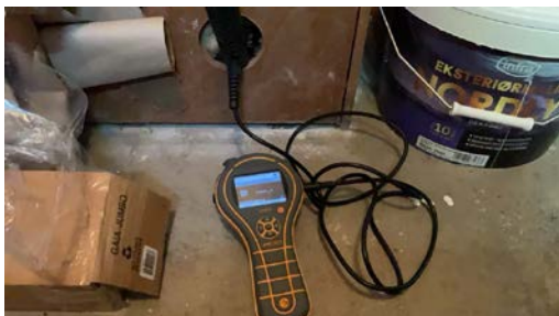
Ved fuktmåling ble det registrert tørre verdier
