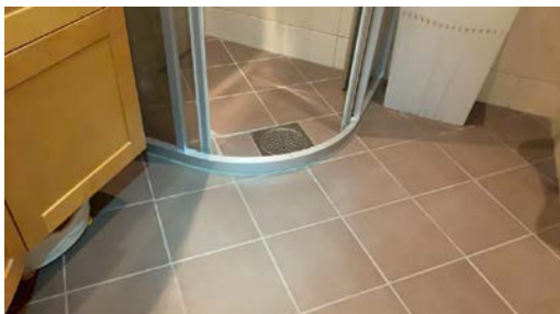
Det er ikke spalte i terskel mot sluk, slik at evt. lekkasjevann vil renne ut av våtrommet i stedet for ned i sluk.
