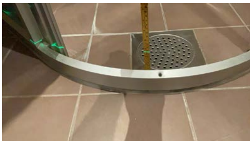
Målt fall til sluk: 16mm.
