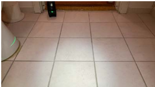
Lokalt motfall ved toalett.
