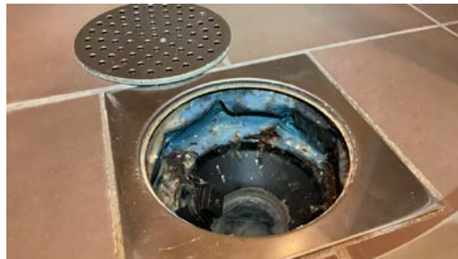
Feil utførelse på mansjett rundt klemring i sluk
