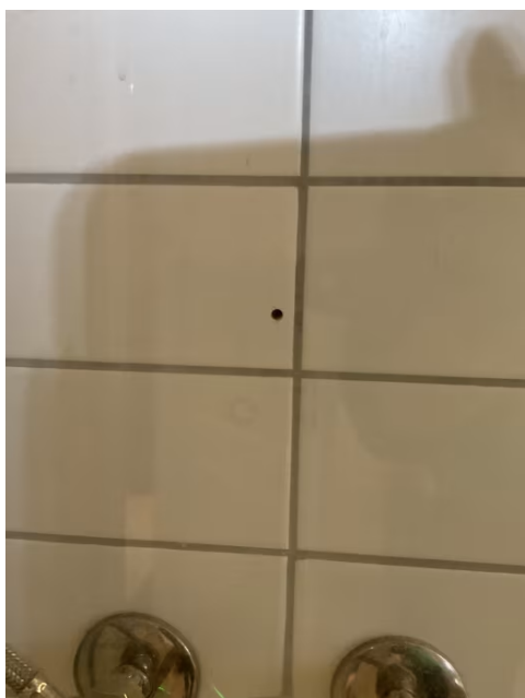
Hull etter tidligere dusjvegg.
