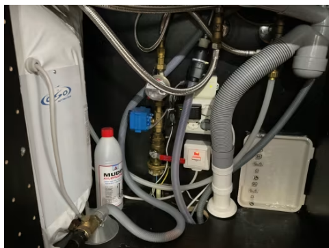
Stoppekran i kjøkkenbenk.
