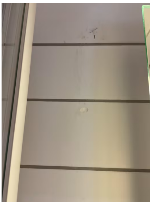
Hull etter tidligere dusjvegg.
