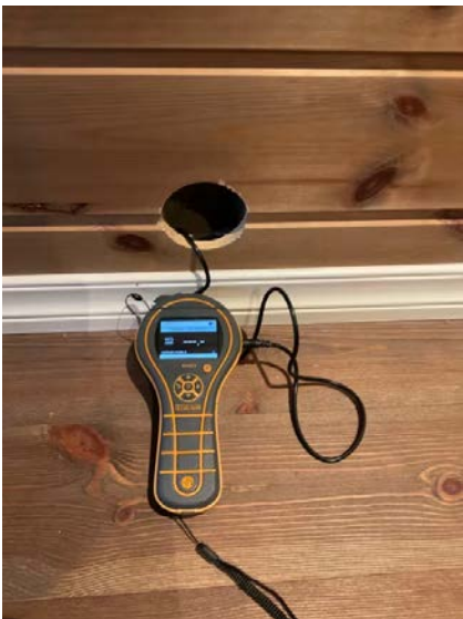
Hulltaking i tilstøtende rom.
