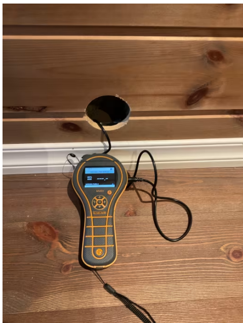
Hulltaking i tilstøtende rom.
