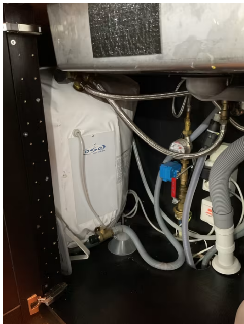
Varmtvannsbereder.
