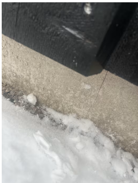
Sprekk i steinplate.
