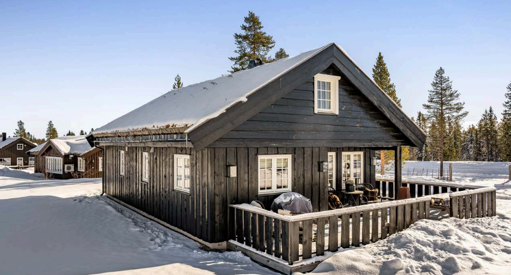
En flott familiehytte fra 2016 som har yttervegger kledd med villmarkspanel og tak tekket med torv.
