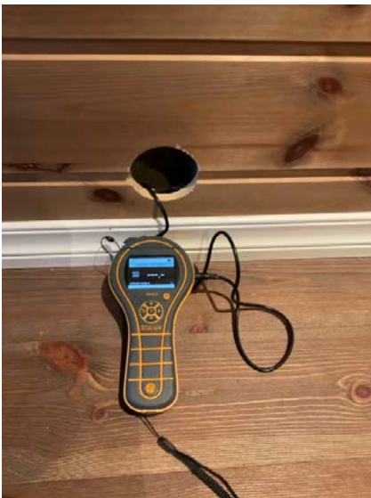
Hulltaking i tilstøtende rom.
