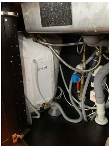
Varmtvannsbereder.
