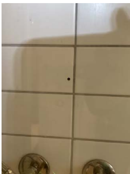
Hull etter tidligere dusjvegg.
