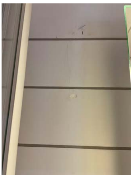
Hull etter tidligere dusjvegg.
