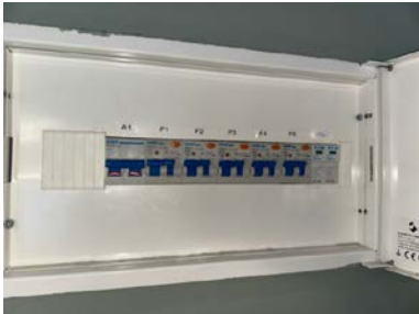
Sikringsskap med automatsikringer.
