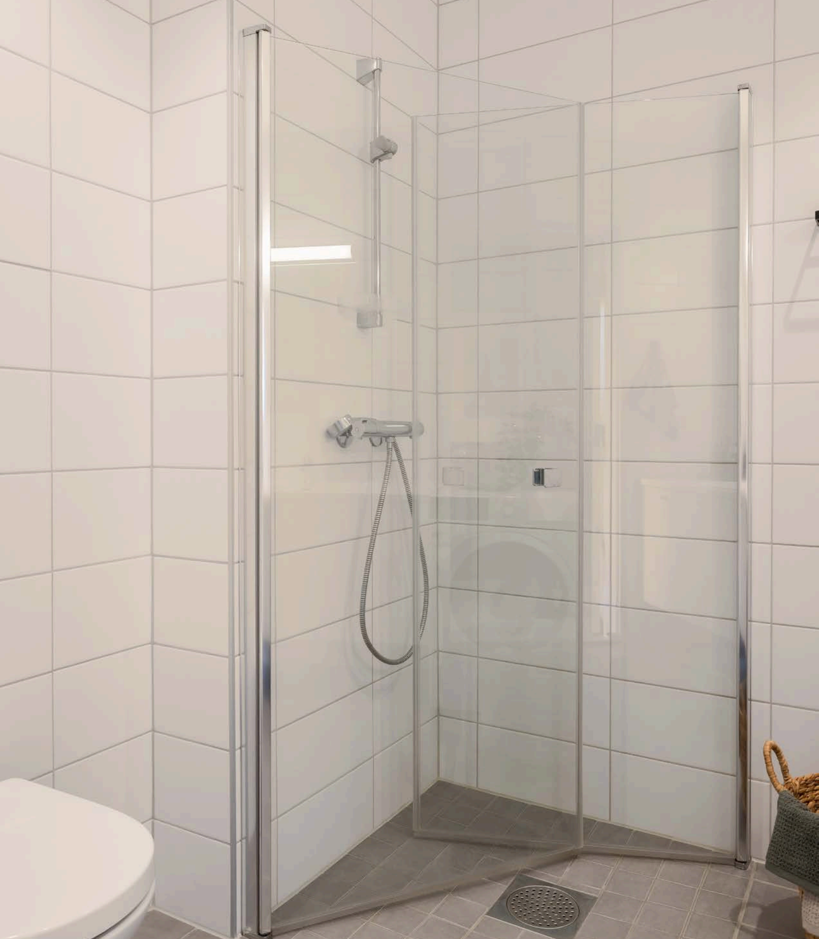
Badet har dusjhjørne med innfellbare dusjdører og vegghengt dusjbatteri.
