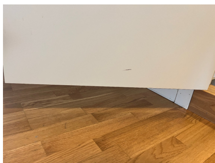
Merke på innvendig dør
