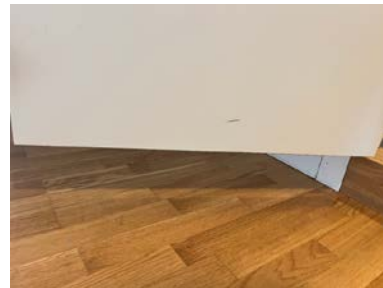
Merke på innvendig dør
