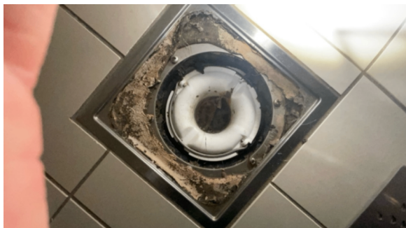
Kontroll av sluk.
