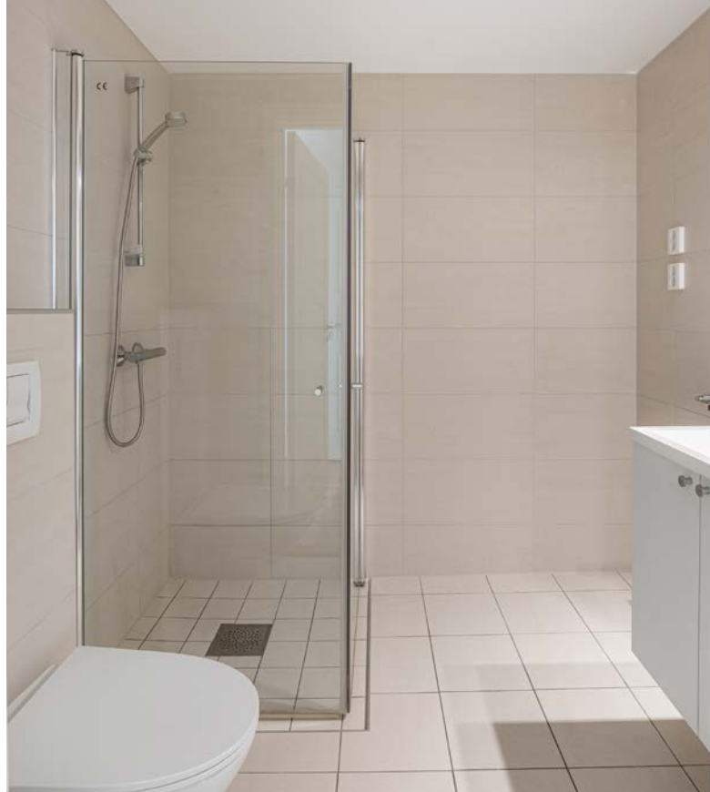
Det er et vegghengt toalett med innebygget systerne.
