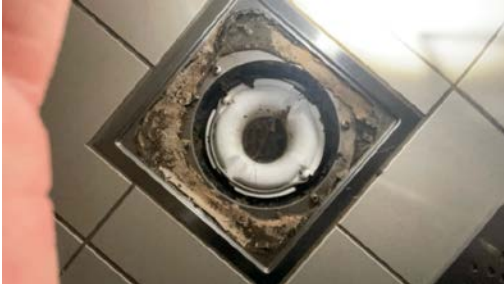
Kontroll av sluk.
