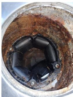
Tettesjiktets tilslutning til sluk - Sluk bad
