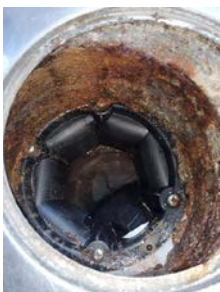
Tettesjiktets tilslutning til sluk - Sluk bad
